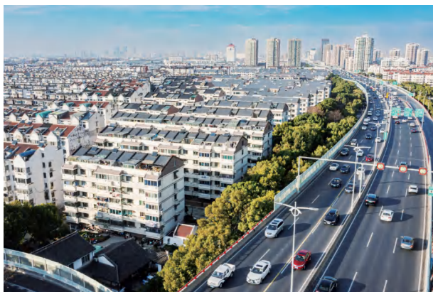
2023年12月,杨枝四村老旧小区改造完工
