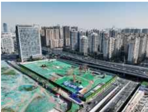
2024年3月20日，恒润中心项目奠基仪式现场
