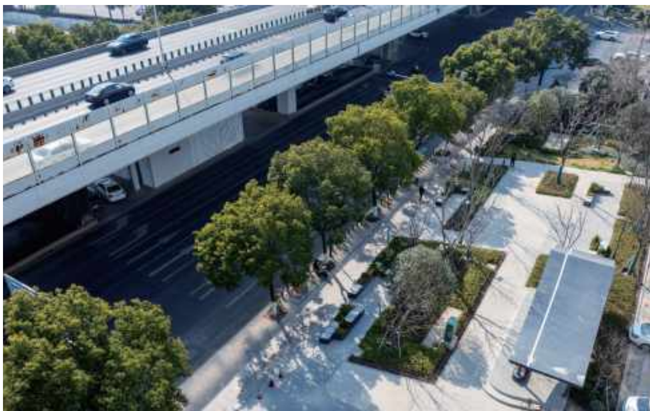
2024年12月，朗诗口袋公园项目竣工
